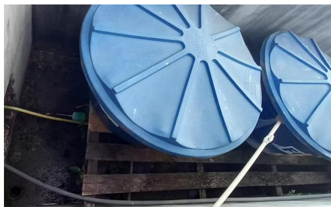
Figura 13 – Dreno para escoamento da água
