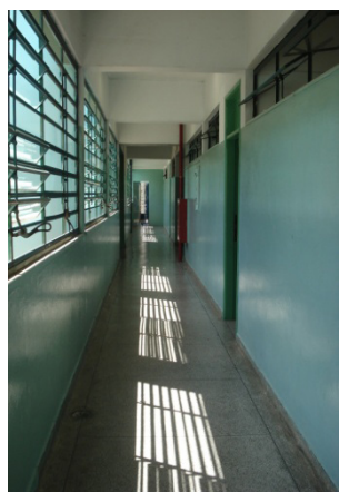
Corredor de acesso às salas de aula / Bloco inferior
