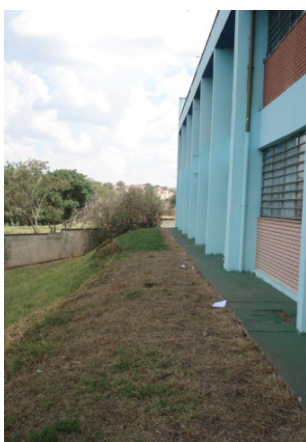
Lado externo / Janelas das salas de aula
