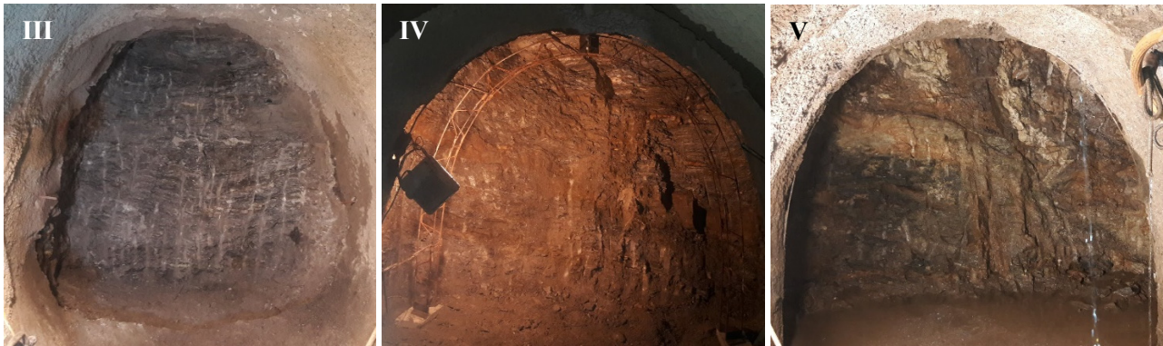
Figura 3 – Fotografia das frentes de escavação em classes III (seção plena), IV (seção parcializada com cambota) e V (seção parcializada com cambota, DHPs e enfilagens).
