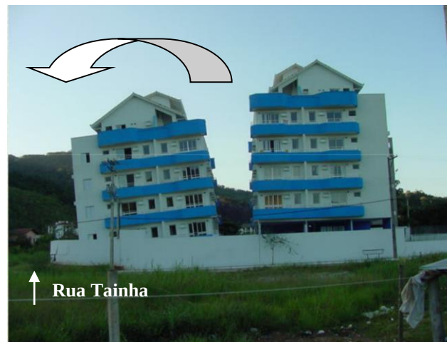
Figura 2. Nova configuração do edifício após o colapso.
