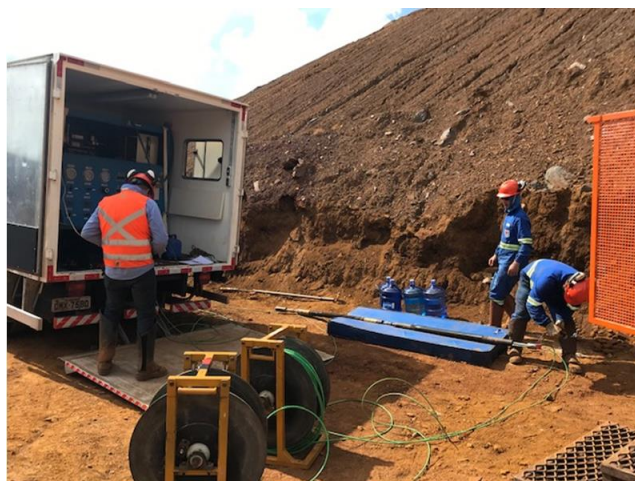
Figura 5 - Furo FG-00001 – Praça do ensaio e obturador utilizado no ensaio de Fraturamento Hidráulico.
