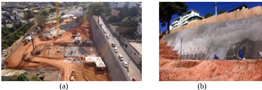
Figura 1. Execução da contenção em solo grampeado estudada.
