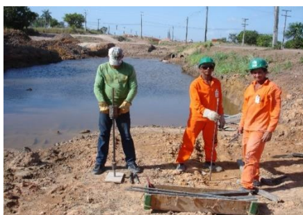
Figura 8. Execução de ensaio DPL.
