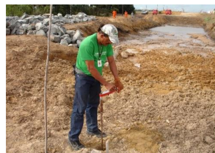
Figura 9. Preparação para execução do ensaio “vane-test”.
