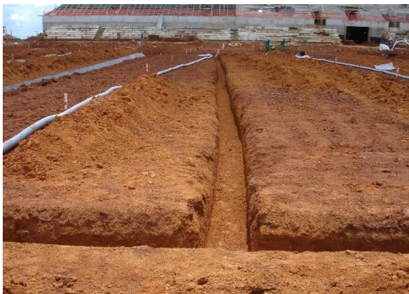
Figura 14. Trincheiras limpas para instalação do geocomposto drenante.
