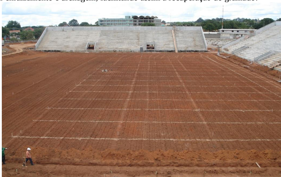
Figura 11. Marcação do gabarito das linhas drenantes.
