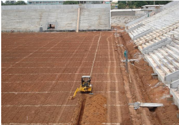
Figura 12. Abertura das trincheiras longitudinais.
