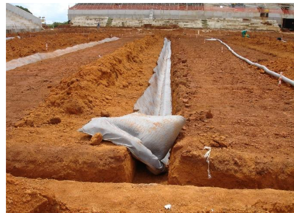
Figura 15. Instalação do geocomposto drenante.
