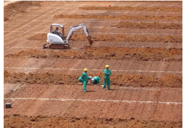
Figura 13. Abertura das trincheiras transversais.
