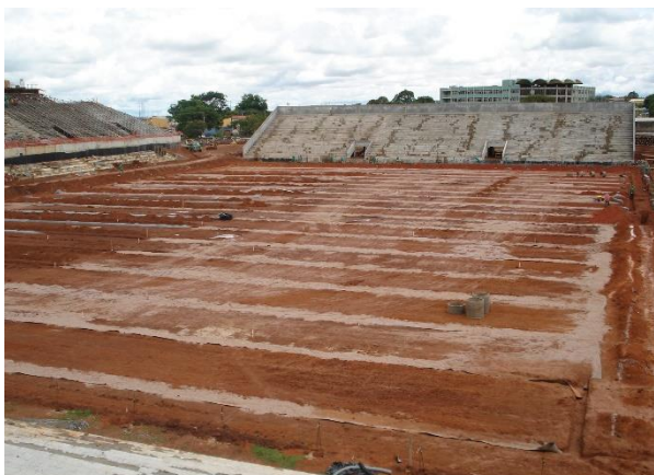
Figura 16. Preenchimento das trincheiras com areia lavada.
