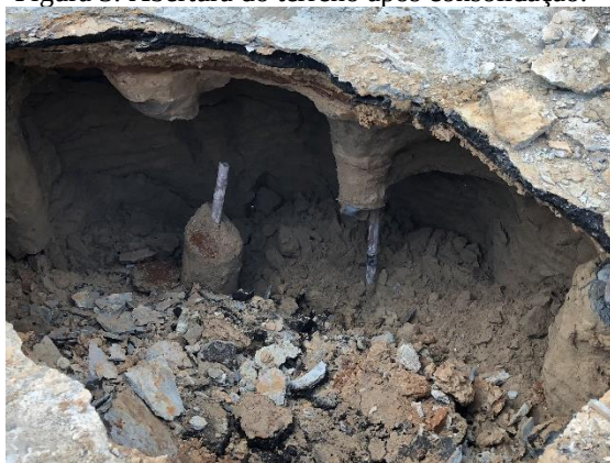
Figura 3: Abertura do terreno após consolidação.
