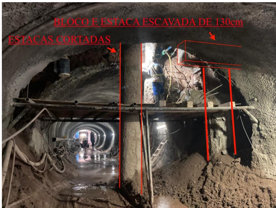
Figura 7. Seção escavada sendo preparadas as estacas para concretagem.
