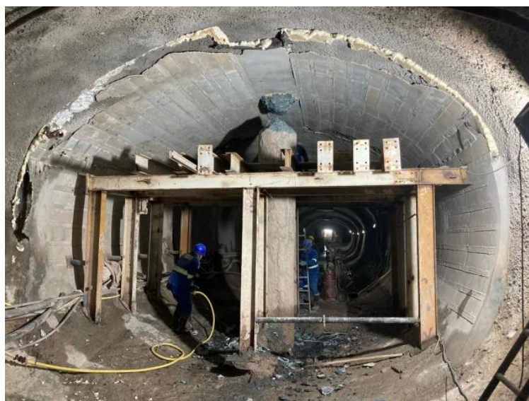
Figura 8. Seção finalizada após corte das estacas.
