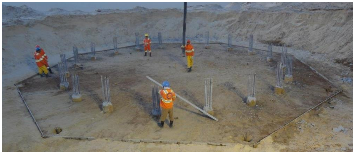
Figura 3. Base com as estacas raiz executadas e arrasadas (em preparação para concreto magro).
