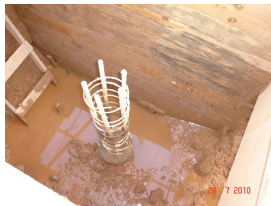
Figura 6 - Detalhes da execução da forma da viga de reforço e da estaca raiz.
