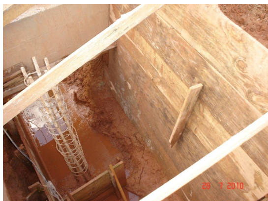
Figura 6 - Detalhes da execução da forma da viga de reforço e da estaca raiz.
