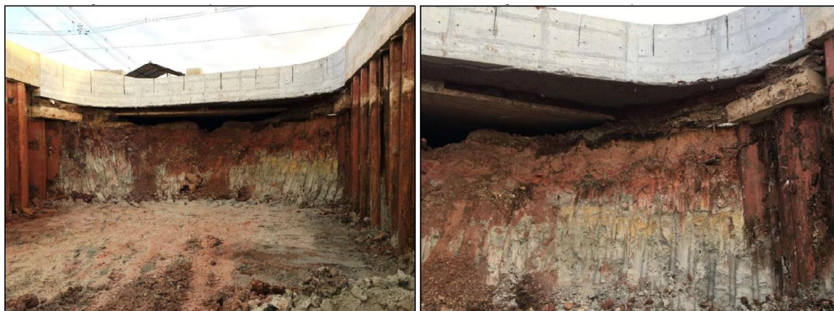
Figura 2 – Nspt antes e durante as obras
