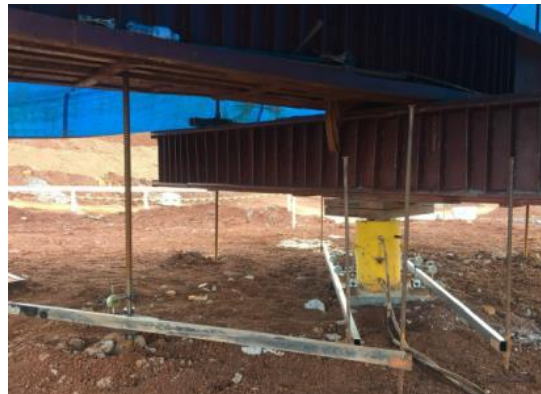
Figura 5. Montagem de uma prova de carga da obra.
