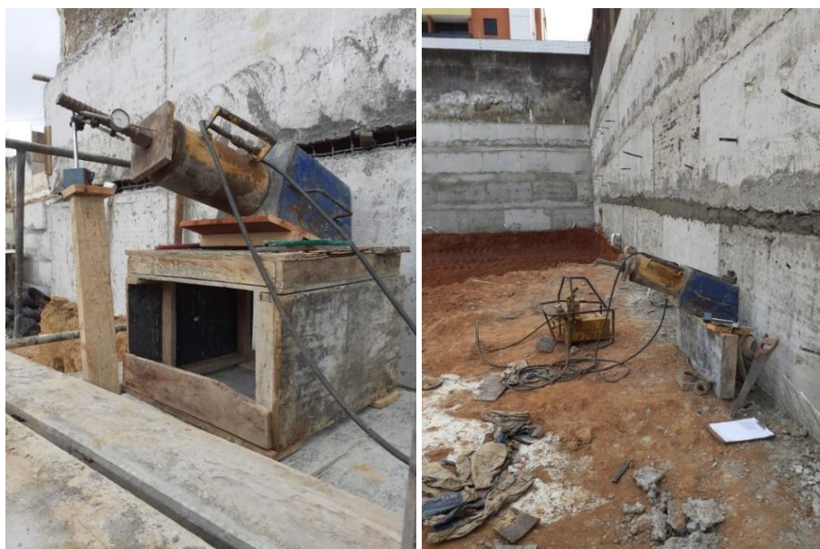
Figura 5. Execução do ensaio de arrancamento (autores, 2021).
