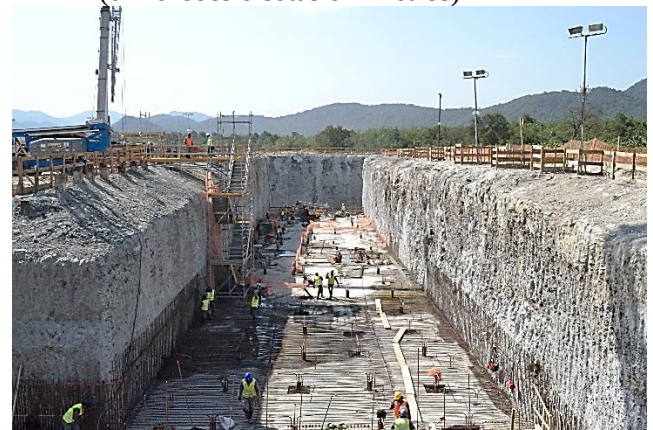
Figura 4 - Vista geral do Setor C.
