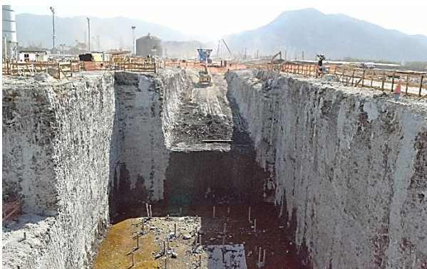
Figura 5 - Vista do Setor A (rampa) a partir do Setor B.
