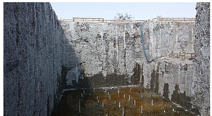
Figura 6 - Vista Geral do Setor B, com Setor C na lateral
