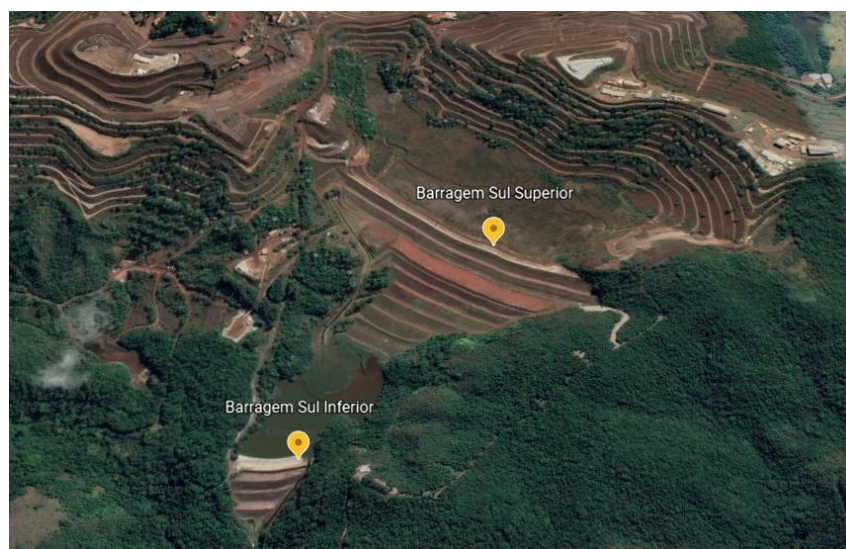
Figura 1. Localização das Barragens Sul Superior e Sul Inferior. Fonte: Google earth, 2021.
