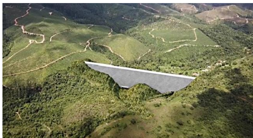
Figura 2. Estrutura de Contenção à Jusante (ECJ). Fonte: Adaptado de Plano De Mitigação De Impactos Em Estruturas e Áreas Sensíveis, PAEBM, 2021.
