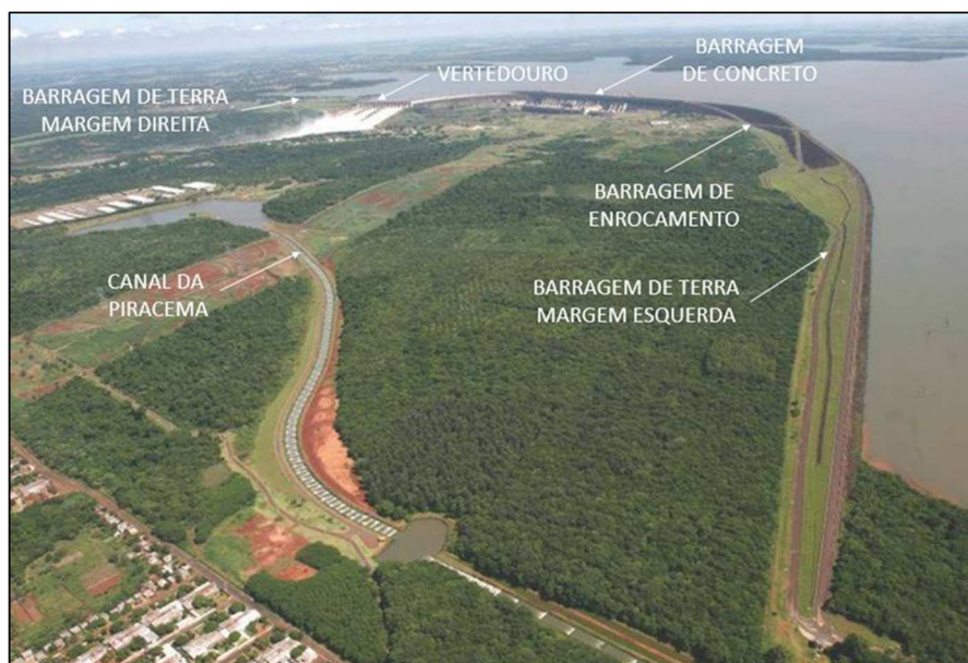
Figura 1 - Vista geral da barragem de Itaipu a partir da BTME (Adaptada de Itaipu Binacional, 2009)
