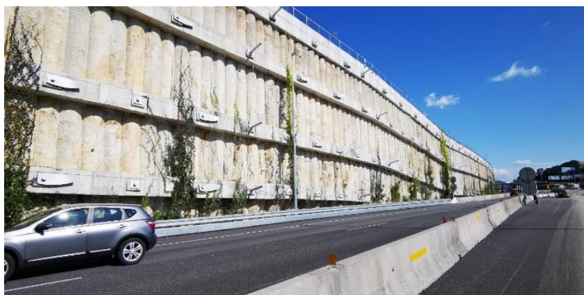
Figura 7. Contenção ancorada no emboquilhamento nascente
