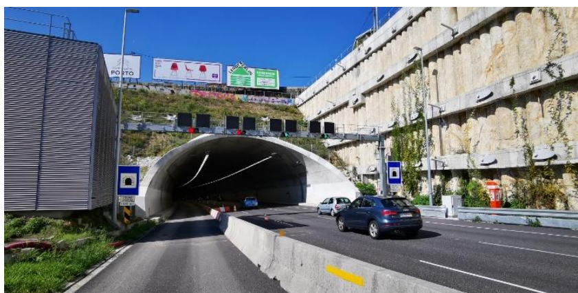
Figura 6. Emboquilhamento nascente do Novo Túnel de Águas Santas
