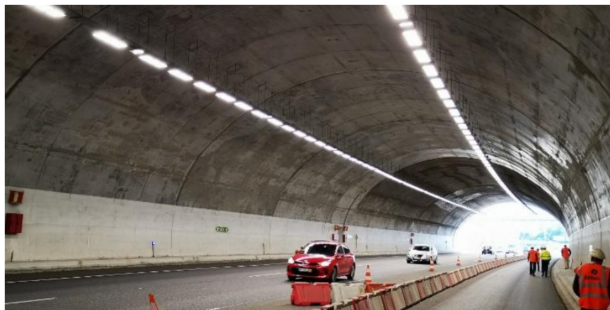
Figura 1. Novo Túnel de águas Santas
