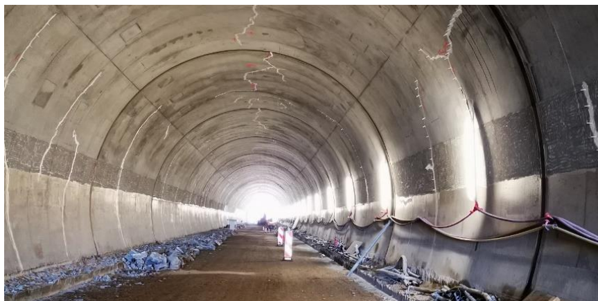
Figura 3. Reabilitação das galerias existentes
