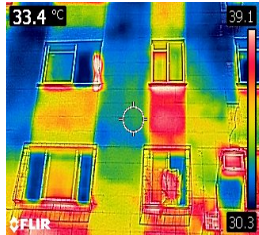
Figura 8 - Fachada Norte – Imagem termográfica
