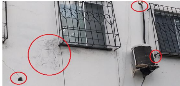
Figura 13. Grades e Ar Condicionado nas Fachadas
