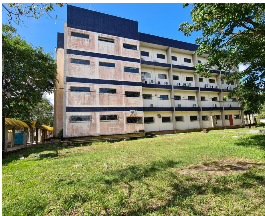
Figura 5 - Fotografia da fachada Norte
