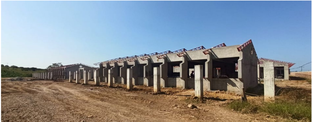
Figura 3. Perspectiva da fachada da obra.
