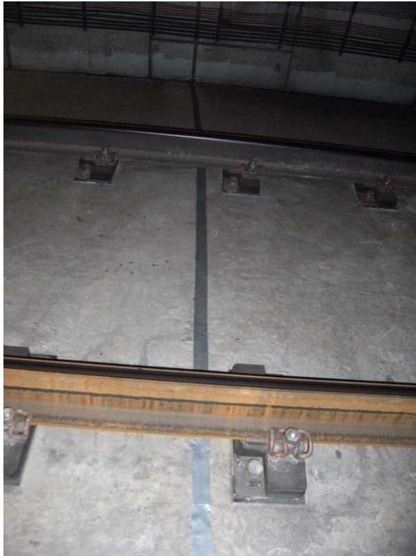
Figura 12. Fibra instalada y protegida en vía.
