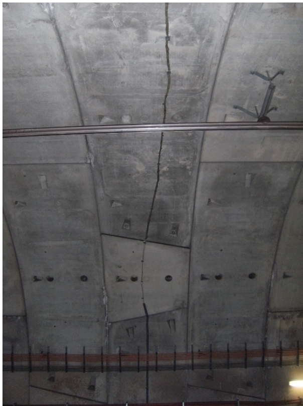
Figura 13. Fibra instalada y protegida en bóveda.
