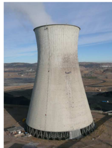
Figura 2. Aplicación a una torre de refrigeración.
