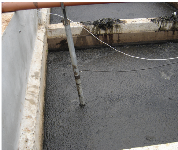
Figura 12 – Remoção do lodo dos tanques
