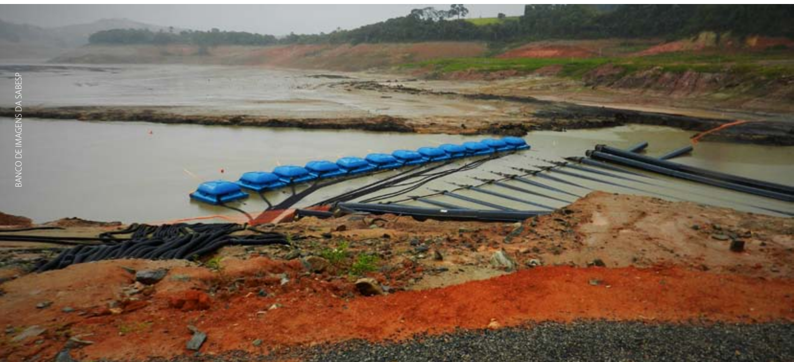
Figura 5 - Obras de instalação do bombeamento para captação de água do volume morto do Sistema Cantareira
