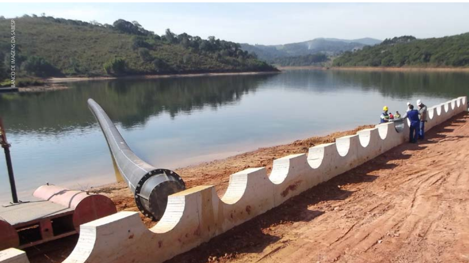
Figura 2 - Obras de instalação do bombeamento para captação de água do volume morto do Sistema Cantareira
