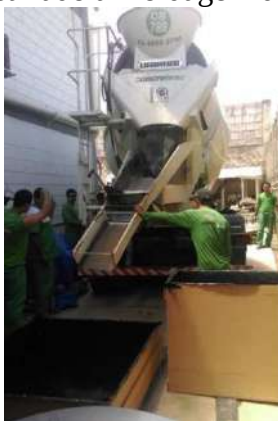
Figura 20 – Local destinado à moldagem dos blocos de concreto.
