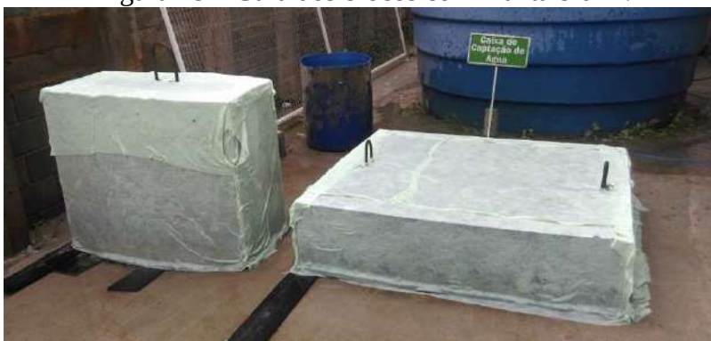
Figura 28 – Cura dos blocos com manta bidim.
