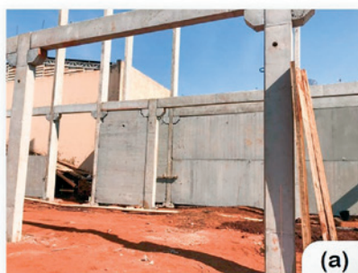
► Figura 3 Execução dos elementos estruturais e dos painéis de vedação (a) e modelagem 3D dos elementos estruturais e dos painéis de vedação (b) Fonte: Autoria própria (2021)
