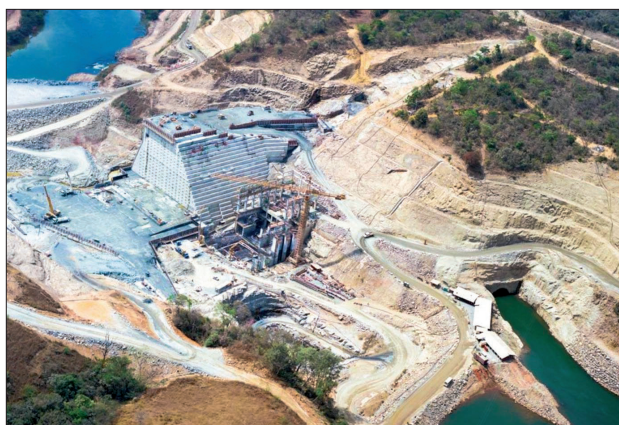
FIGURA 3 BARRAGEM DE CCR – UHE SERRA DO FACÃO
