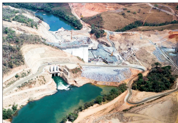
FIGURA 4 BARRAGEM DE CCR E TÚNEL DE DESVIO
