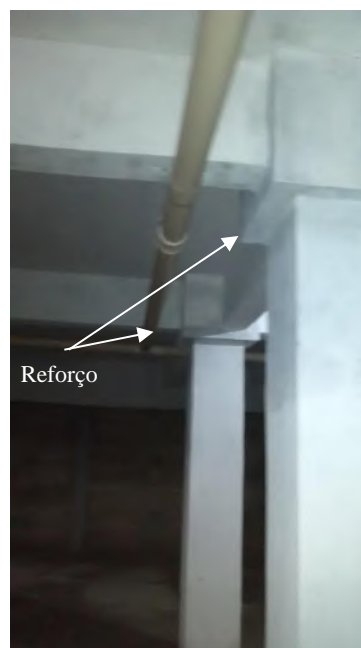
Figura 11: Reforço com grout nos pilares P06 e P16. (fonte: da autora)
