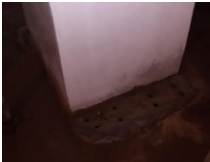
Figura 14: Furos no segundo subsolo para aplicação do grout nos pilares do pavimento do terceiro subsolo. (fonte: da autora)
