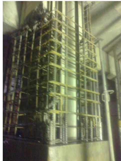
Figura 13: Reforço de armadura no pilar P24. (fonte: da autora)
