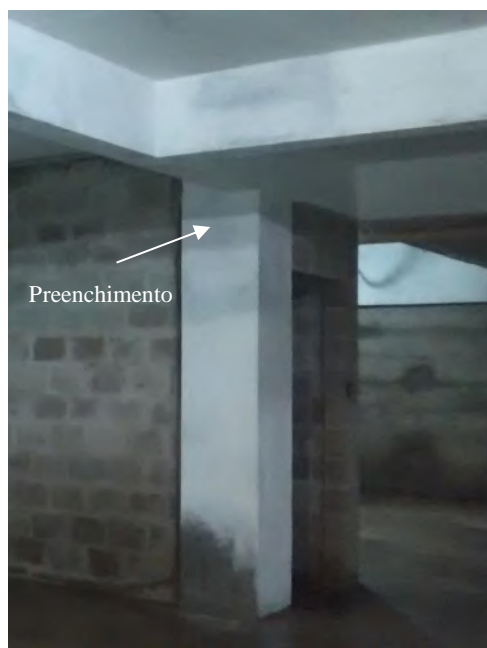
Figura 10 :Preenchimento com grout da falha de concretagem no pilar P12. (fonte: da autora)
