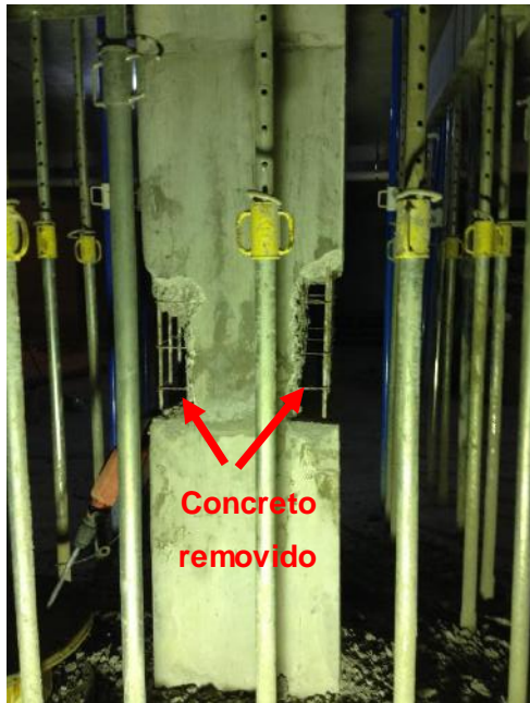
Figura 12: Remoção do concreto degradado e criação de superfície rugosa. (fonte: da autora)
