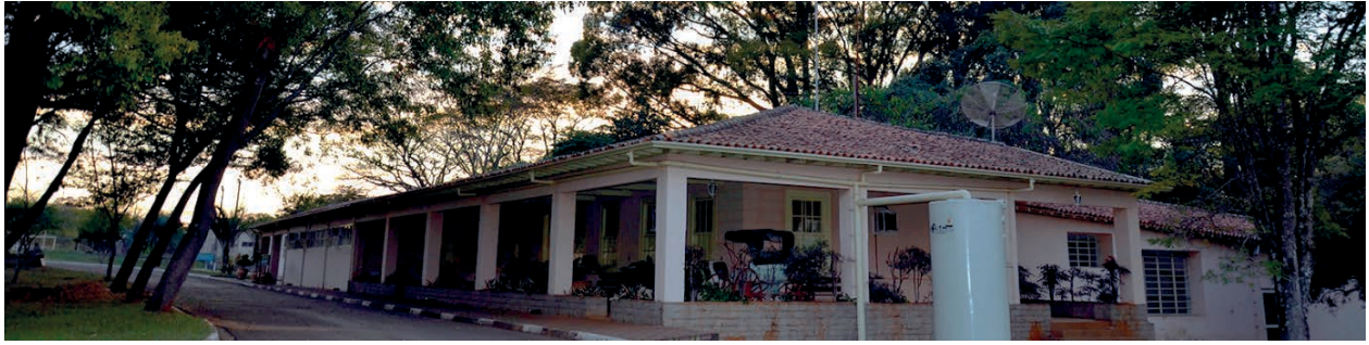
FIGURA 6 - Edifício da administração do campus Araras. Fonte: Universidade Federal de São Carlos (2023b).
