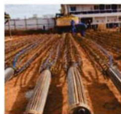
Estaca tipo Expander Body
