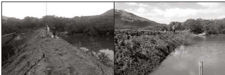
Figura 11 – Visão do colapso da barragem experimental: (a) fissuramento no talude jusante e (b) rachaduras no talude de montante ocasionadas pela diminuição de sucção
