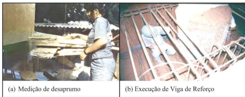
Figura 44 – Monitoramento e recuperação das fundações
