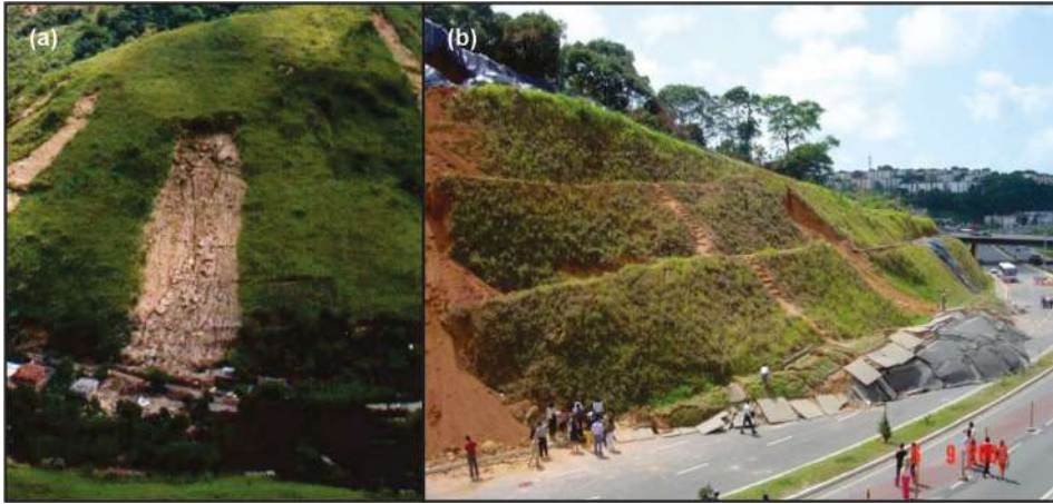
Figura 2 – Exemplos de superfícies de ruptura: (a) Escorregamento translacional em solo residual – Foto do acervo da GeoRio; (b) escorregamento rotacional (Salvador, 2005)
