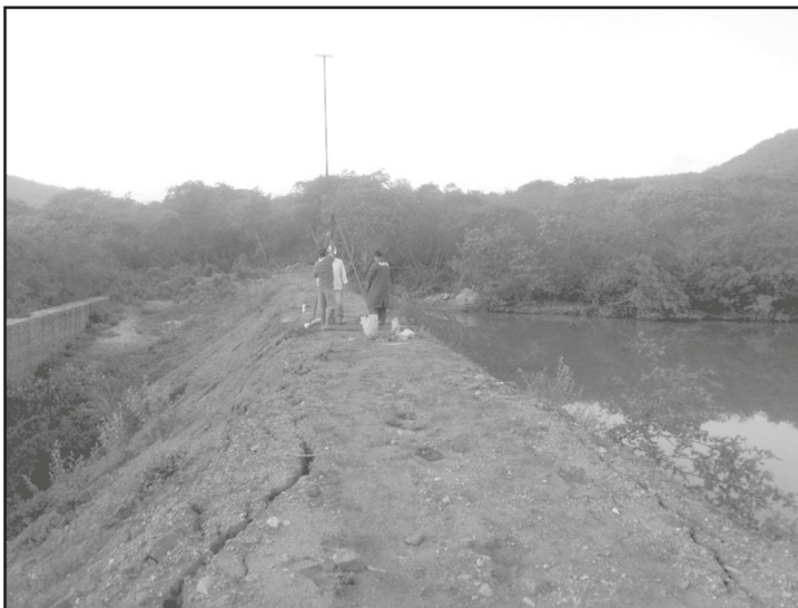
Figura 12 – Detalhe da parte central da Barragem – Núcleo.
