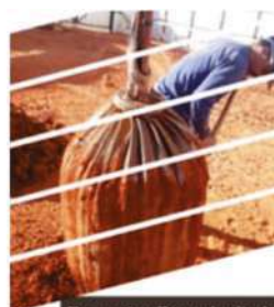
Estaca tipo Expander Body
