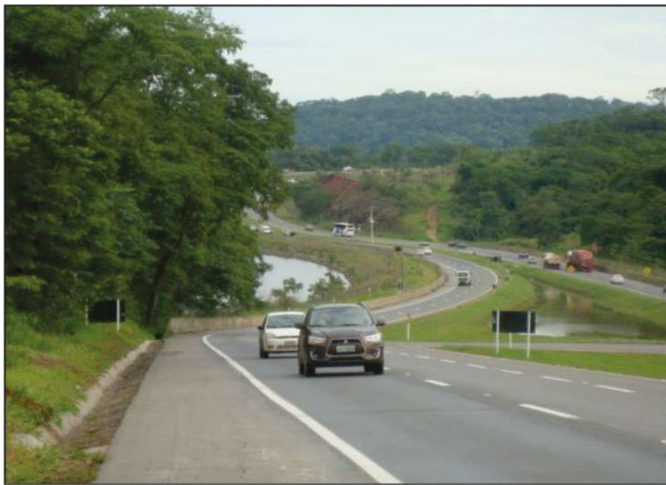
Figura 1 – Aterro na rodovia BR-060 atingido pelo reservatório de água João Leite
