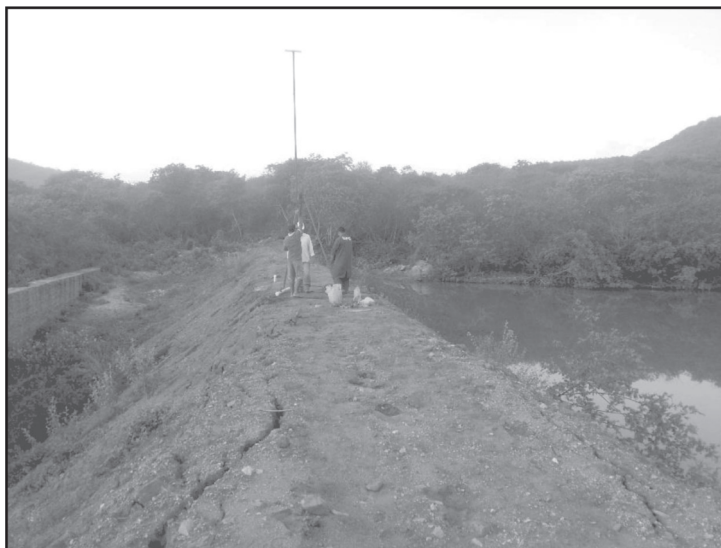
Figura 12 – Detalhe da parte central da Barragem – Núcleo.
