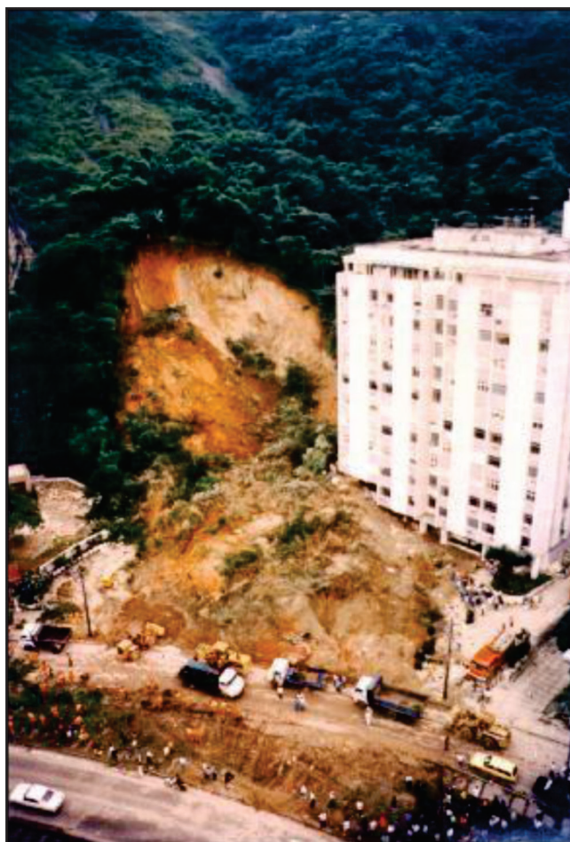
Figura 7 – Caso histórico ruptura de encosta (Gerscovich et al. , 2006)
