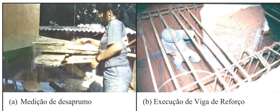
Figura 44 – Monitoramento e recuperação das fundações
