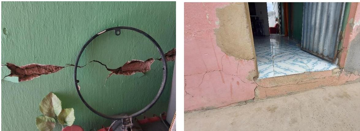
**Figura 8** - Fissuras e trincas em alvenaria de bloco cerâmico. Fonte: autores
