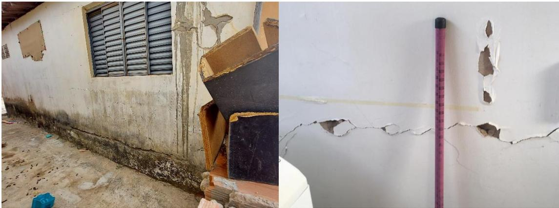
**Figura 14** - Fissuras e trincas horizontais. Fonte: autores
