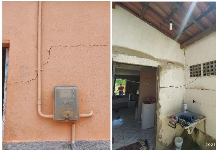
**Figura 9** - Presença de fissuras e trincas próximas de esquadrias. Fonte: autores
