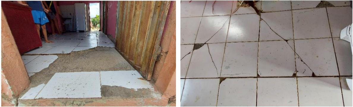
**Figura 7** - Patologias em revestimentos cerâmicos de piso. Fonte: autores
