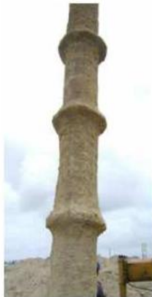
Figura 2. Estaca escavada a seco com anéis extraída.
