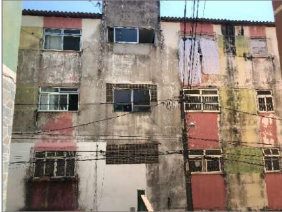
Figura 2 - Edifício A, fachada frontal
