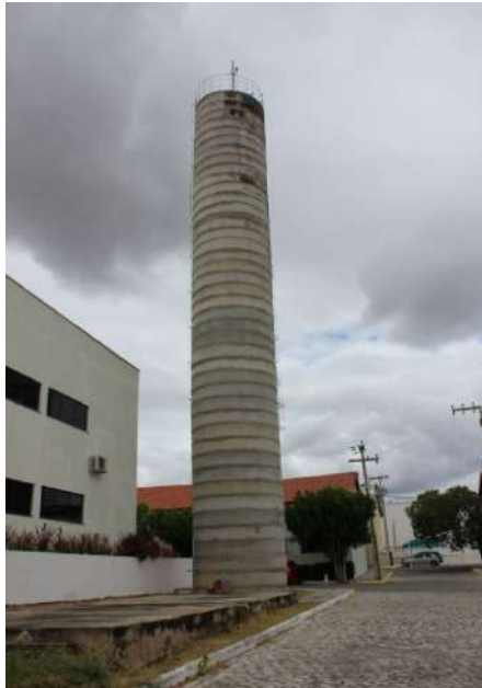
Figura 05. Reservatório 1- Caixa d'água IFCE. Fonte: Autor (2017).
