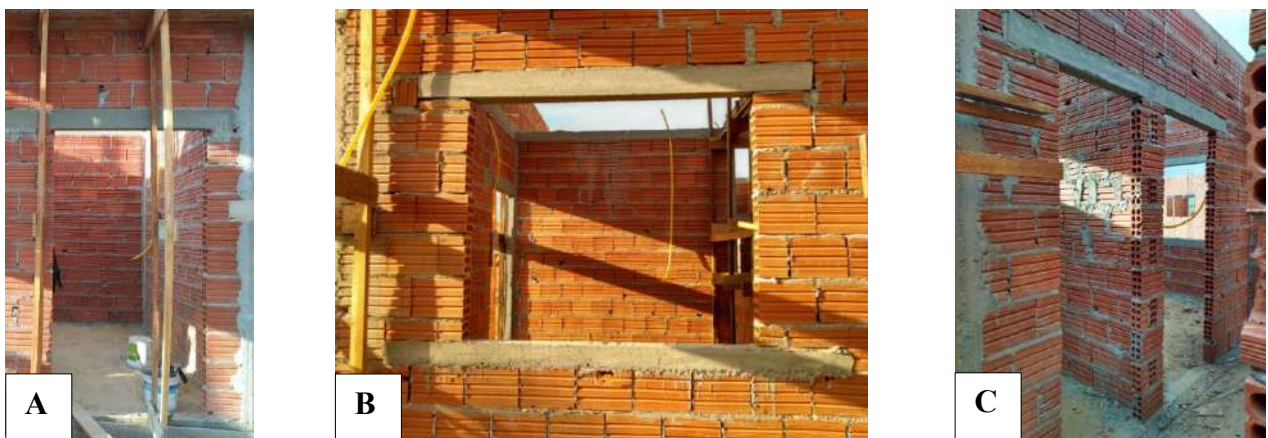
Figura 2- Edificação unifamiliar com presença de verga e contraverga.
