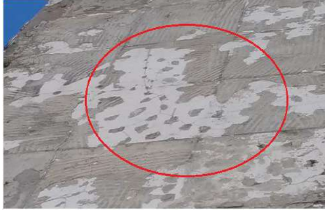
Figura 10 - Argamassa Colante Sobre Pintura
