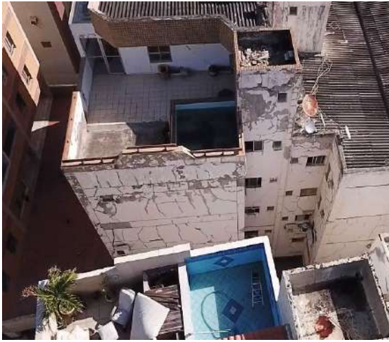
Figura 12: Vista da fachada nordeste do Bloco A.
