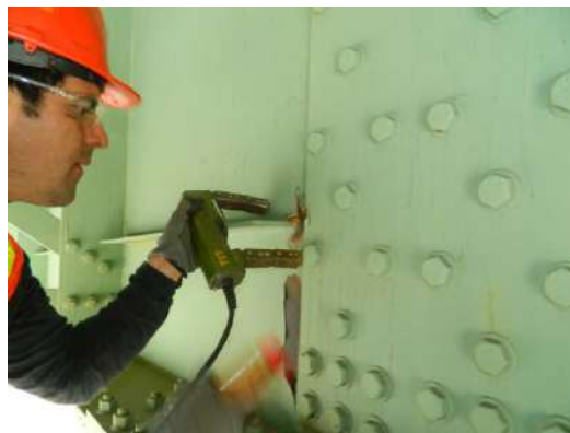
Figura 13. Inspeção por partículas magnéticas. Fonte: Domson Engineering and Inspection (2017)
