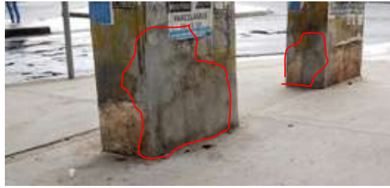
Figura 9 – Recomposição de recobrimento de armadura nos Pilares 7 e 8
