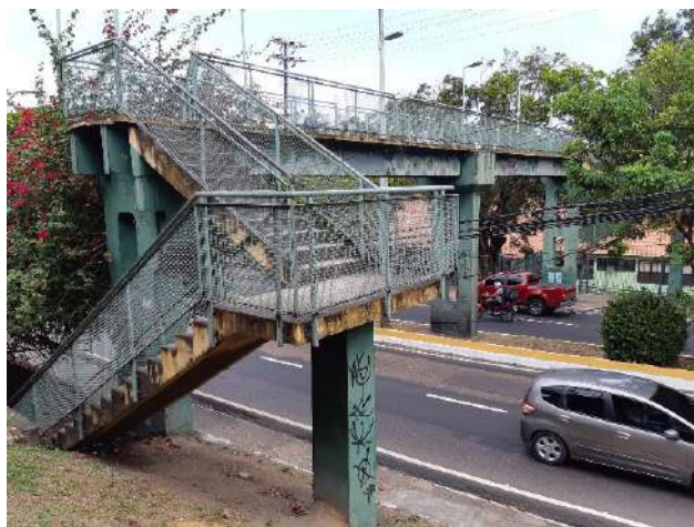
Figura 19: P04, vista do lado norte.
