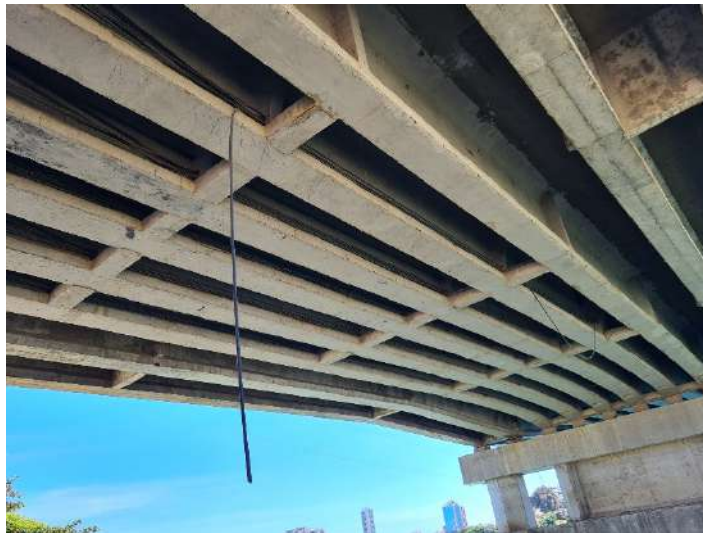
Figura 5. Vista da parte inferior da ponte.
