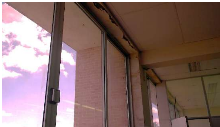
Figura 4 – Imagem da esquadria de um dos laboratórios da edificação.
