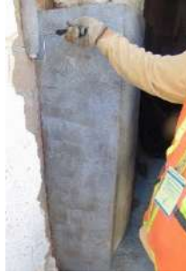
Figura. 6. Proceso de reparación profunda uniforme
