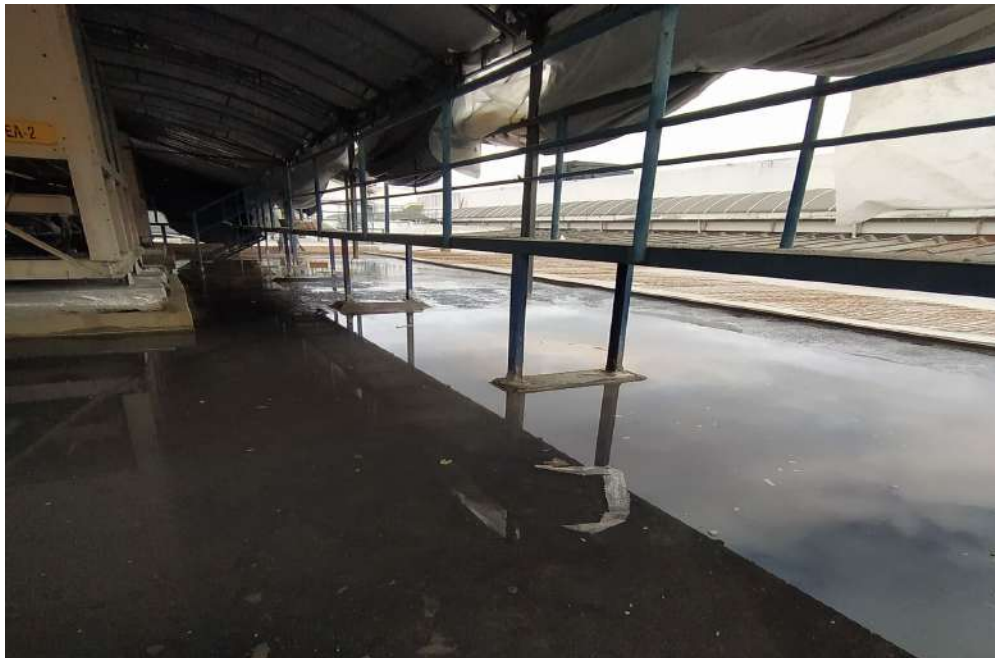
Figura 6: Prueba de estanqueidad.
