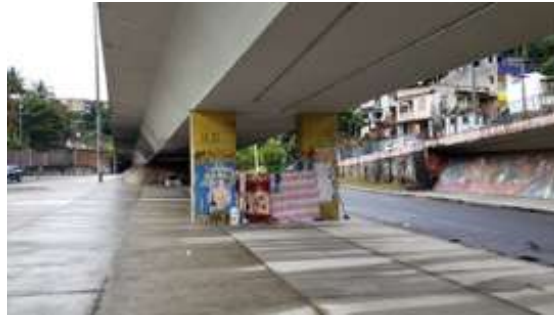
Figura 11 – Vista Vãos 1 e 2, Pilares 1 e 2
