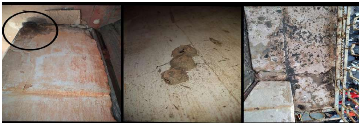
Figura 9. Bolor e fungo em: (A) Bolor em alvenaria, (B) Fungo e (C) Bolor na sacada (Autor, 2021).
