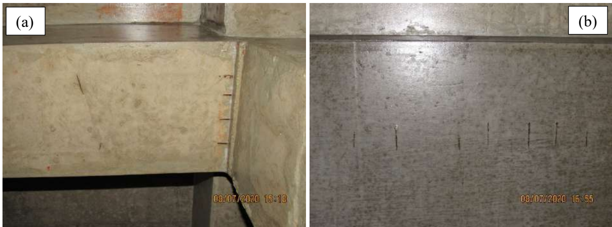
Figura 2. Registros fotográficos das anomalias associadas a causas intrínsecas à estrutura: a) exposição das armaduras na viga V1b, localizada no primeiro nível da garagem; b) exposição das armaduras na laje L12, no segundo nível da garagem.
