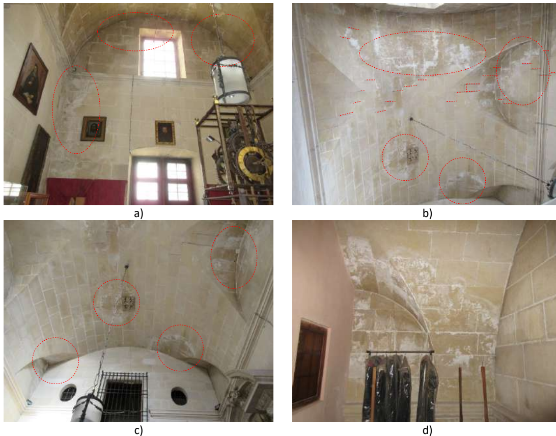
Figura 2. Fotos de salas bajo cubierta 2: a) Fachada Este, b) Vista inferior de la cubierta, c) Vista inferior de cubierta con tabique divisorio de bóveda, d) Sala anexa superior tras división con tabique.
