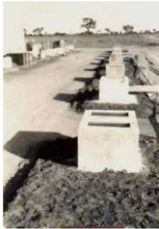
Figura 3 - Cavidades nas sapatas com o intuito de receberem os pilares pré-moldados.
