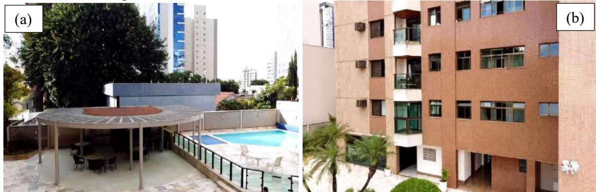
Figura 3. Pavimento Pilotis, que se encontra acima do 2º nível da garagem: a) local onde serão tratadas as falhas de estanqueidade da laje do 2º nível da garagem e após teste de percussão no piso; b) vista de pilares existentes no pavimento pilotis.
