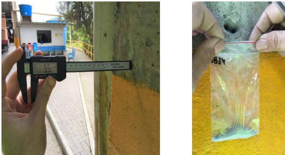
Figura 6. Verificação da profundidade da coleta e armazenamento do pó
