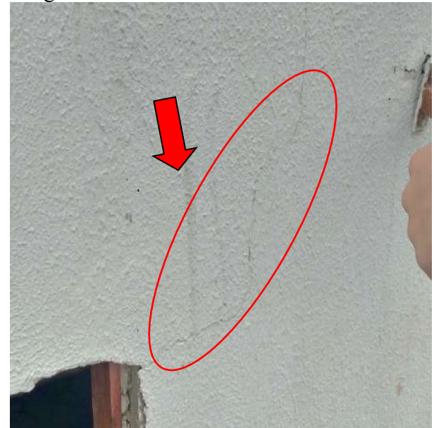
Figura 4. Reenquadramento da abertura.
