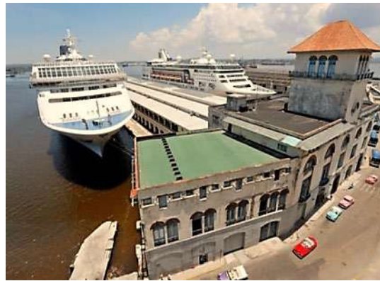
Figura.1. Vista de la terminal de cruceros en la bahía de la Habana. La estructura de hormigón armado arriba a la derecha es la que está siendo sometida a los trabajos de ampliación.
