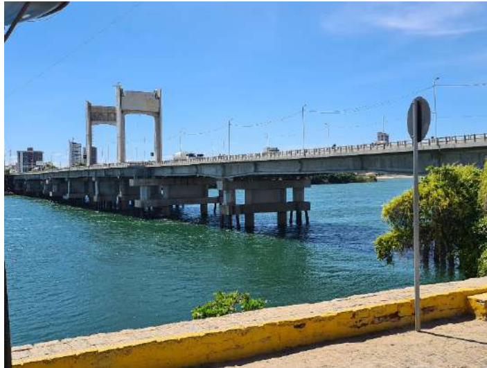
Figura 4. Vista geral da ponte.
