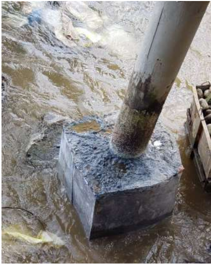
Figura 4: Aspecto final do bloco da ponte.
