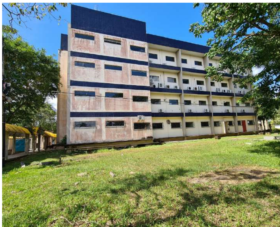
Figura 5 - Fotografia da fachada Norte
