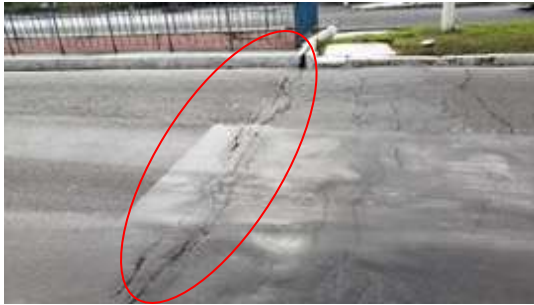
Figura 16 – Pavimento sobre junta de dilatação
