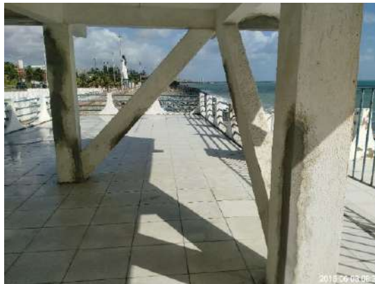
Figura 9. Recuperação dos pilares de sustentação da edificação. Fonte: própria, 2018.
