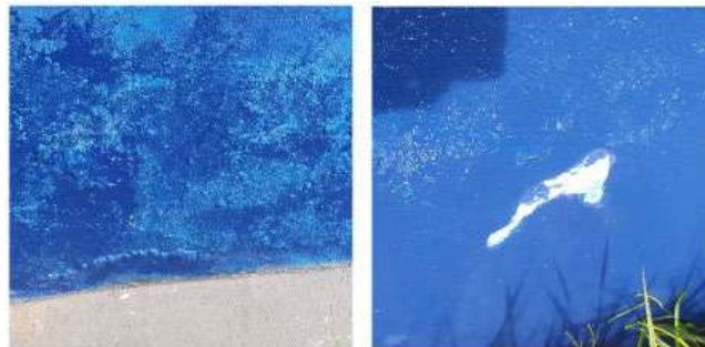
Figura 8. Problemas com umidade ascensional
