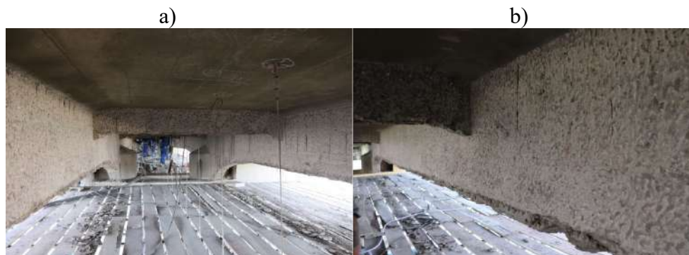
Figura 8. a) Vigas principais e transversina escarificadas b) Viga principal escarificada
