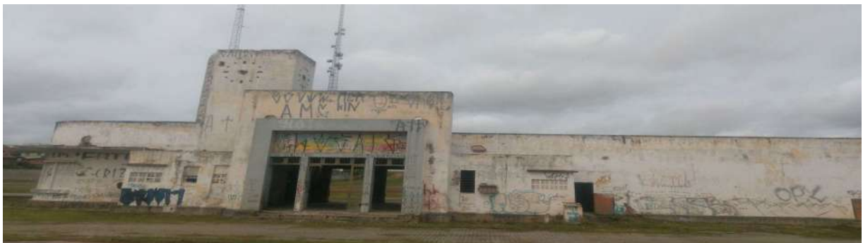
Figura 05 Fachada principal estação nova Fonte: acervo próprio (2021)
