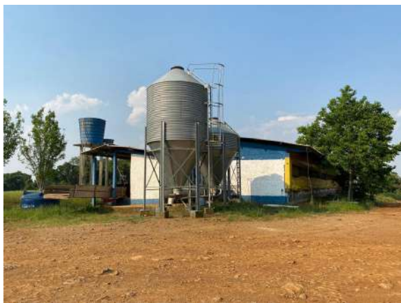
Figura 4 – Fachada da edificação A
