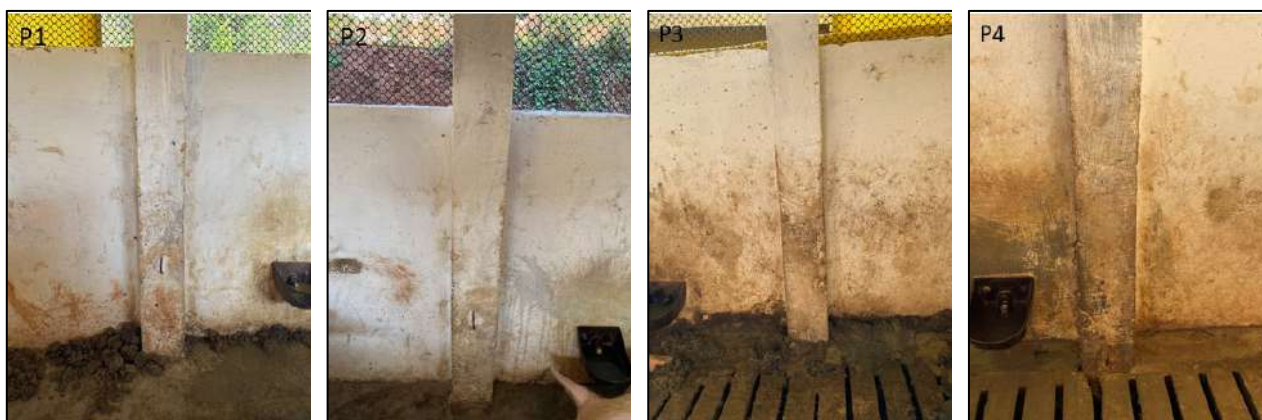
Figura 13 – Aspecto visual dos pilares da edificação C
