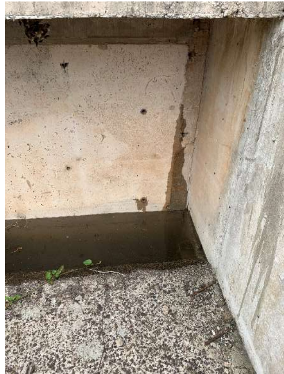
Encontro da parede 4 com a parede 1
