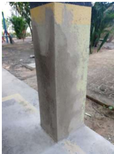
Figura 10. Pilar recuperado pelo método convencional. Fonte: própria, 2019.
