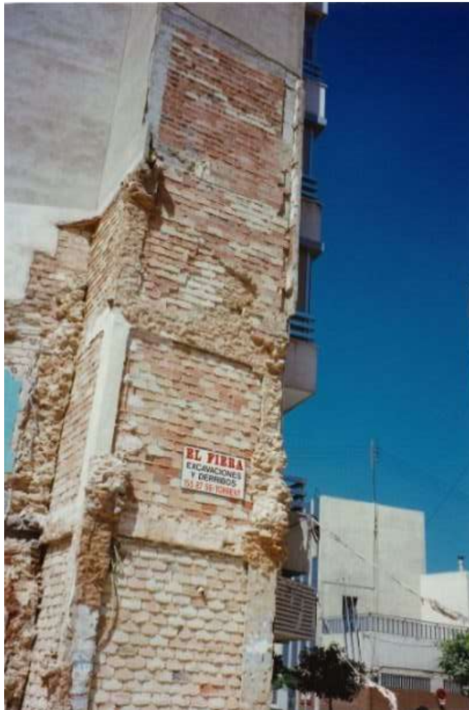
Figura 7. Empresa “El Fiero. Excavaciones y Derribos”.
