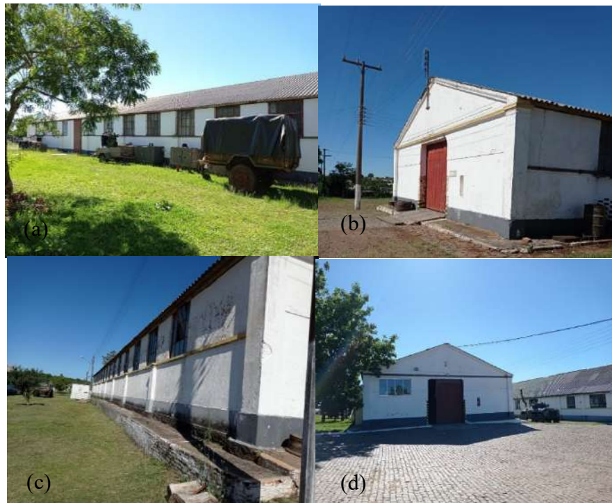
Figura 4. Panorama atual da edificação. (a) Fachada Norte. (b) Fachada Leste. (c) Fachada Sul. (d) Fachada Oeste
