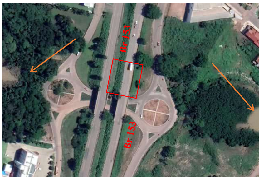
Figura 1. Localização da ponte e cursor d'água (Google Earth, 2021)
