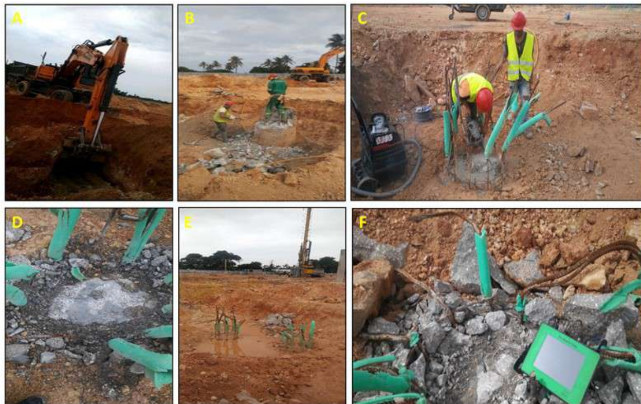
Figura 3. Procesos de preparación de la cabeza del pilote para ensayos de integridad. factores que obstaculizan el proceso de ensayo. A. Descubrimiento del pilote. B. descabezado con martillo hidráulico. C. Planeado de la superficie de la cabeza del pilote. D. Segregación de hormigón en la cabeza del pilote. E. Presencia de agua en la superficie, humedad permanente. F. Irregularidades en la superficie de la cabeza por Planeado incorrecto
