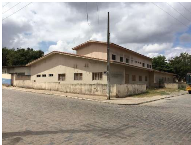
Figura 1. Vista frontal da edificação.
