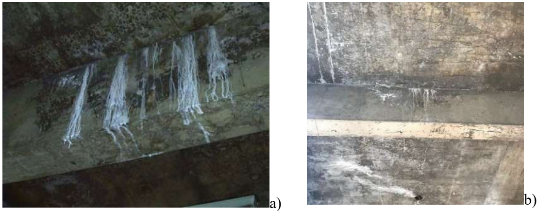
Figura 13 – Análise de 2001(Figura a) e atual (Figura b, em 2021) da incidência de eflorescência na Reitoria.
