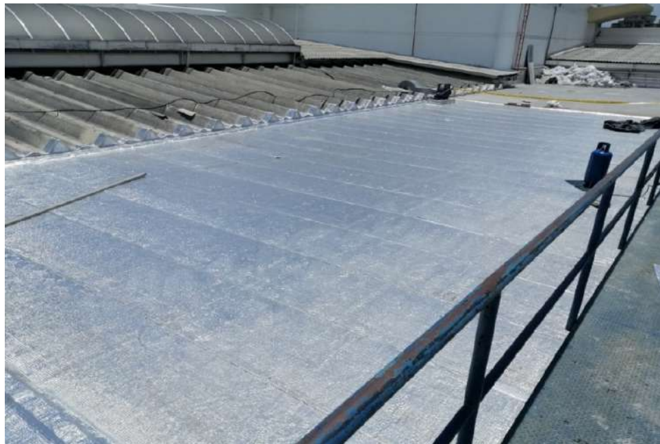
Figura 8: Recubrimiento de protección con manto multicapa fabricado con base en asfaltos no oxidados modificados, con refuerzo central de fibra de vidrio y con acabado en foil de aluminio gofrado.
