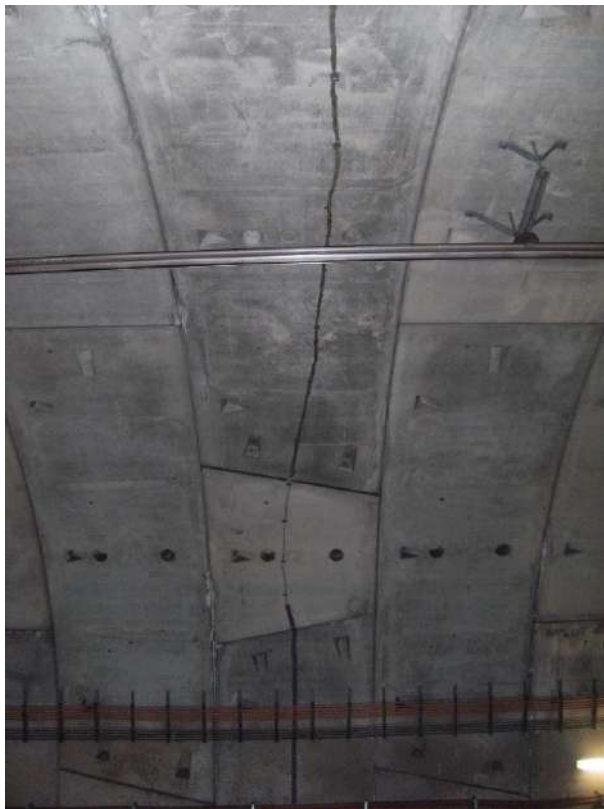
Figura 13. Fibra instalada y protegida en bóveda.
