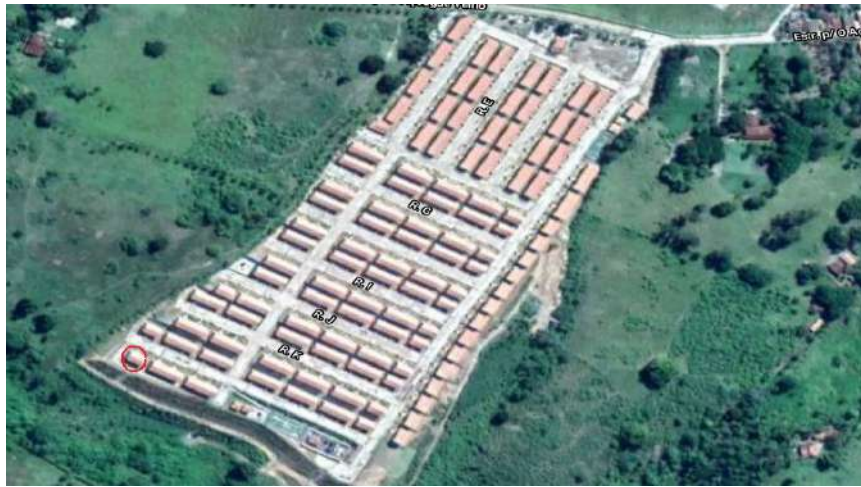
Figura 1. Caracterização da área de estudo e seleção da edificação estudada. Fonte: Google Maps.
