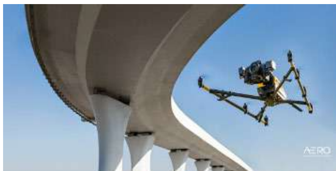
Figura 9. Utilização de drone em inspeção visual. Fonte: Aero Engenharia (2017)
