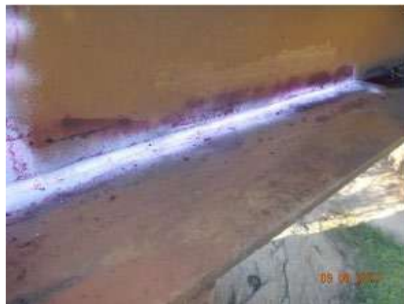
Figura 14. Ensaio por líquido penetrante em perfil de aço soldado.
