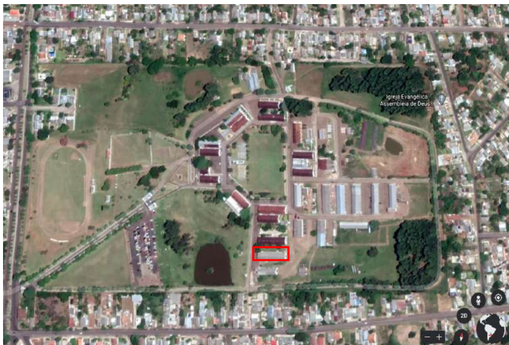
Figura 3. Localização da edificação alvo do estudo
