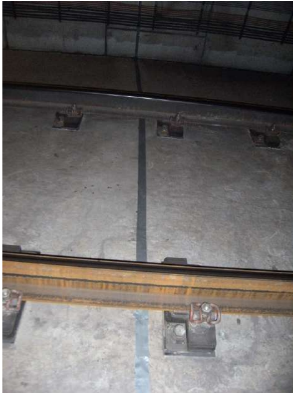
Figura 12. Fibra instalada y protegida en vía.
