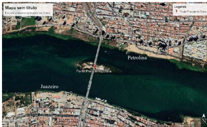
Figura 3. Vista da ponte observada no mapa (Google Earth).
