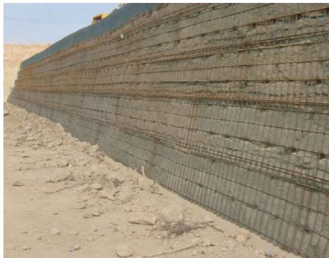
Figura 2. “Muro verde” recién ejecutado.
