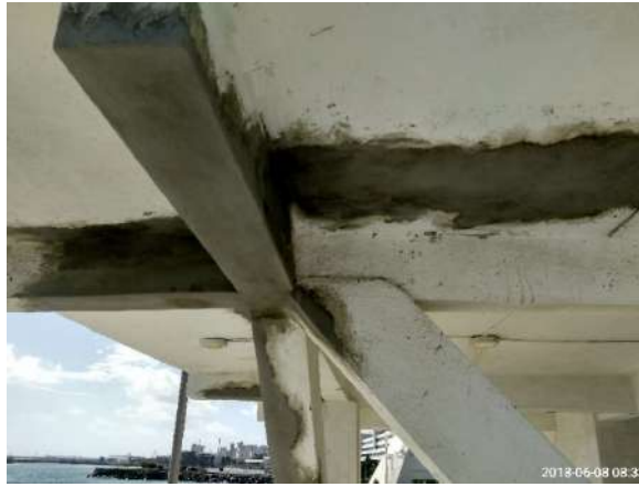
Figura 6. Recuperação das vigas (método convencional). Fonte: própria, 2018.
