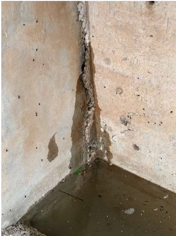
Encontro da parede 4 com a parede 2
