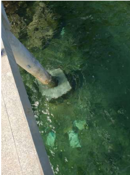
Figura 8 Aspecto final do bloco da ponte do píer.
