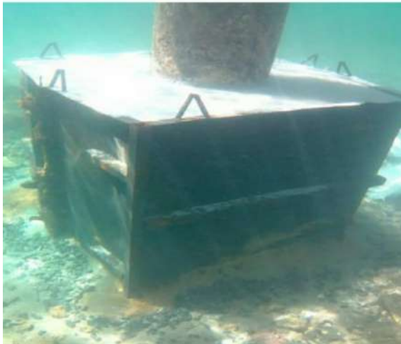
Figura 10 Aspecto final do bloco da ponte do píer.
