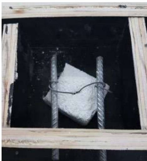
Figura 6. Preparação da fôrma com espaçador industrializado de argamassa.
