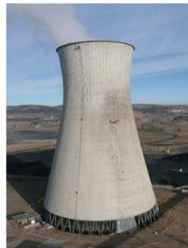
Figura 2. Aplicación a una torre de refrigeración.
