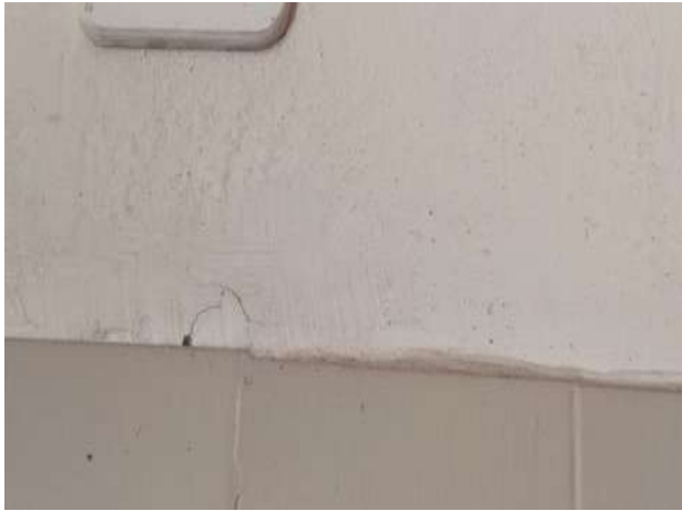
Figura 18- Parede do lado direito, segunda vista frontal. Patologia: fissura. Fonte: Os autores, 2021.
