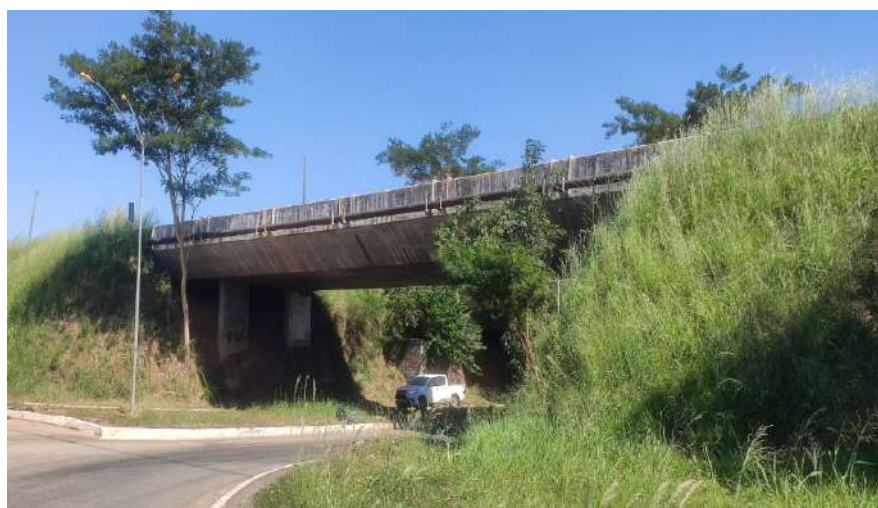
Figura 2. Vista Lateral da Ponte.
