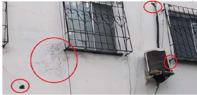
Figura 13. Grades e Ar Condicionado nas Fachadas
