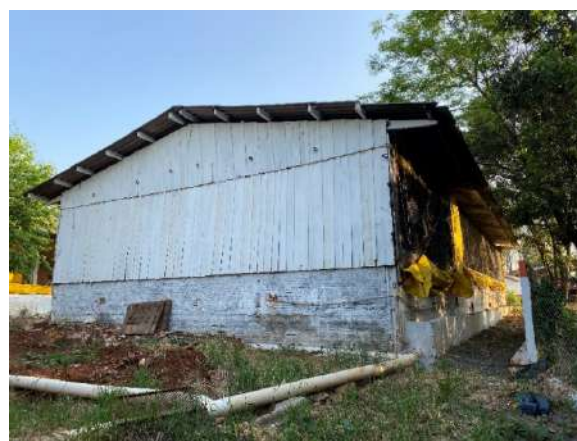
Figura 5 – Fachada da edificação B
