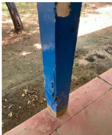
Figura 6: Deslocamento do pilar
