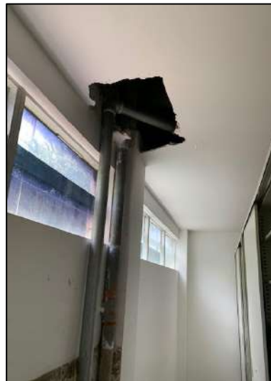
Figura 9 - Abertura de intervenção no forro de gesso. Fonte: (Autoria própria, 2020)
