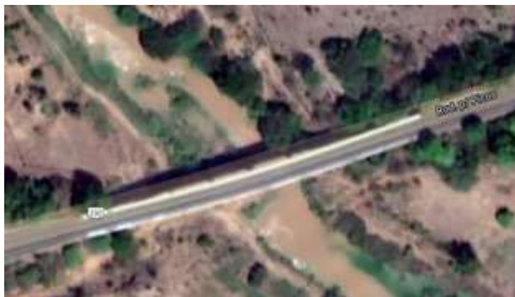
Figura 2. Localização da ponte sobre o Rio Canindé.
