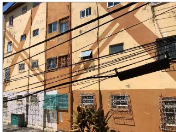
Figura 5 - Edifício B, fachada posterior
