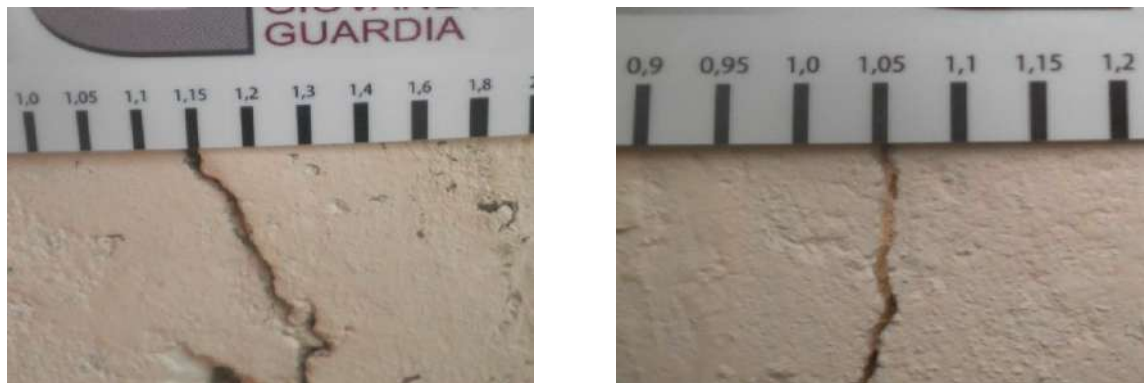
Figura 3.13. Verificação das aberturas nos pilares da quadra utilizando o fissurômetro.
