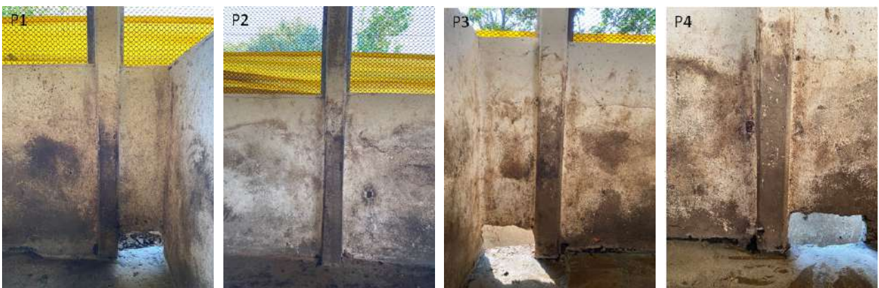
Figura 12 – Aspecto visual dos pilares da edificação B
