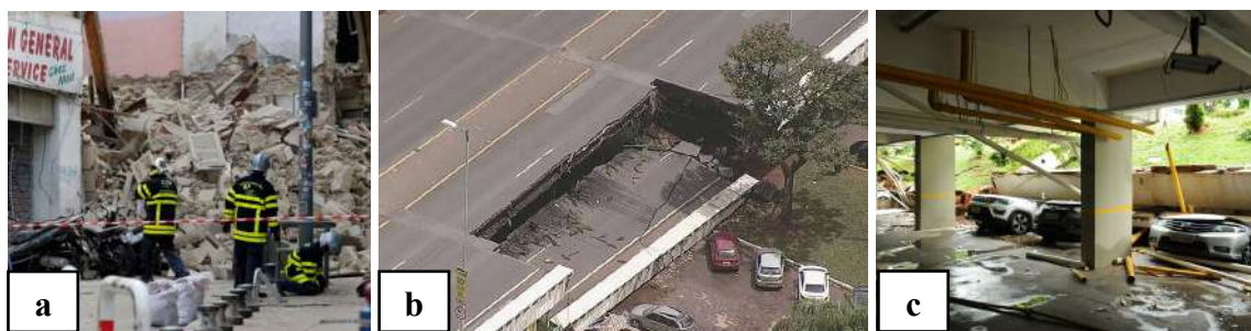
Figura 1 – Desabamentos na construção civil.
