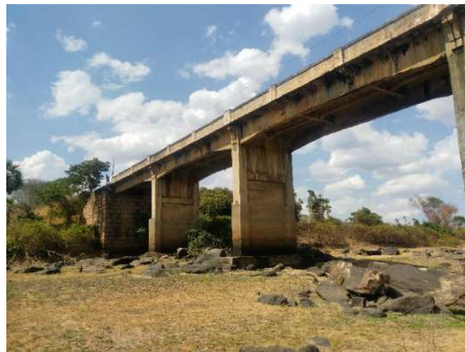
Figura 2. Ponte velha em concreto armado sobre o Rio Aracatiaçu onde temos três pilares em forma retangular. Fonte: própria, 2019.
