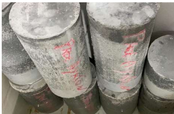
Figura 3 – Acabamento de diferentes amostras após a desforma – Concreto Referência
