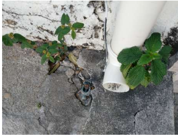
Figura 15. Bolor na parede do lado direito da tubulação e destacamento da tinta da parede. Fonte: própria, 2019.
