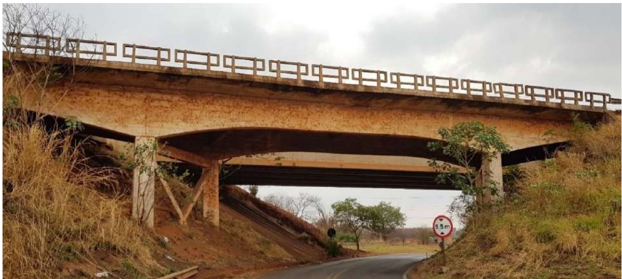
Figura 1. Viaduto em Barretos, SP
