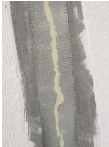
Figura 8. Tratamento de fissura de parede de concreto na Obra A com aplicação de selante, impermeabilizante e tela de poliéster.
