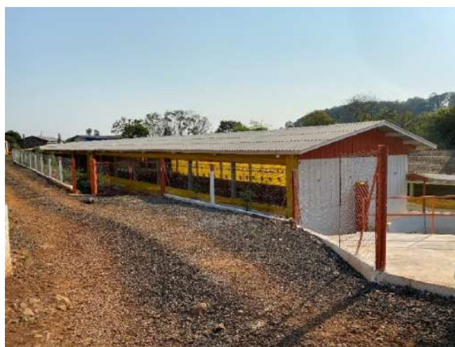
Figura 6 – Fachada da edificação C
