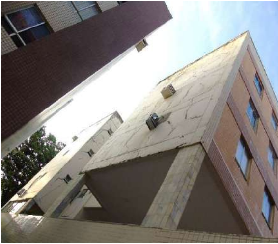
Figura 16: Vista da fachada sudoeste do Bloco A.
