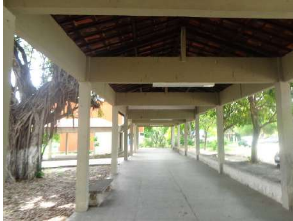
Figura 1. Corredor da UECE construído com estrutura de concreto armado com poucas manifestações patológicas. Fonte: própria, 2021.
