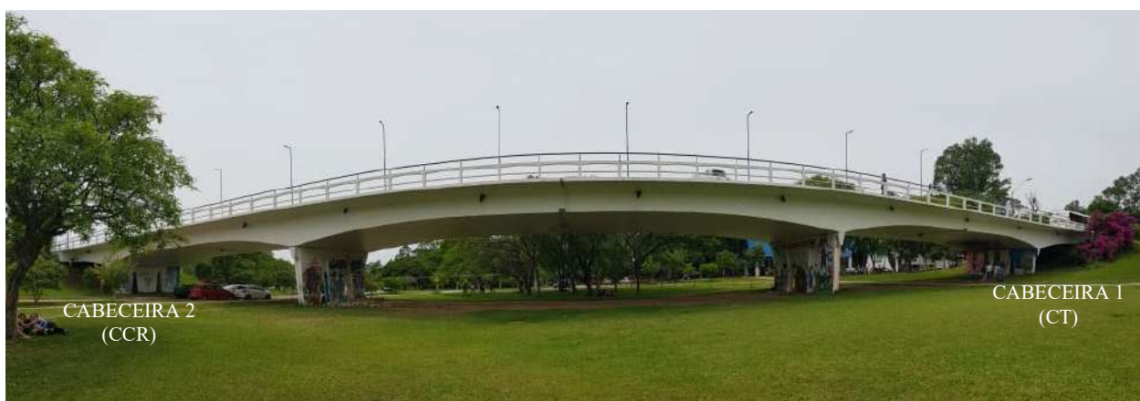
Figura 1. Vista geral da Ponte Marechal Cândido Mariano Rondon no campus da UFSM.
