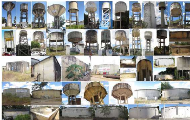
Figura 2. Representação dos 49 reservatórios vistoriados.
