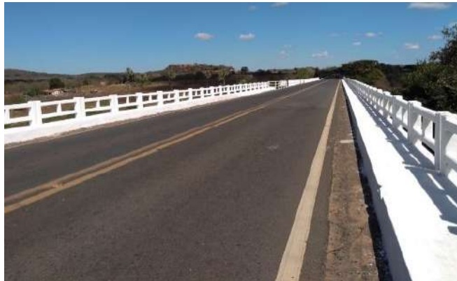
Figura 1. Traçado da ponte sobre o Rio Canindé.
