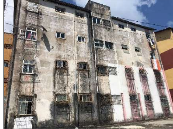
Figura 3 - Edifício A, fachada posterior
