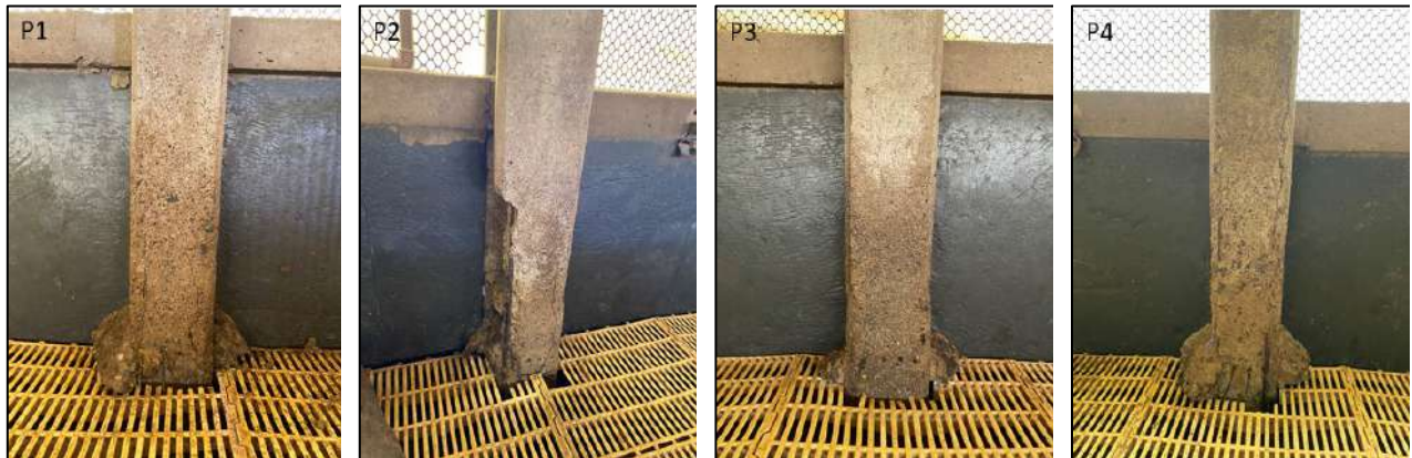
Figura 11 – Aspecto visual dos pilares da edificação A
