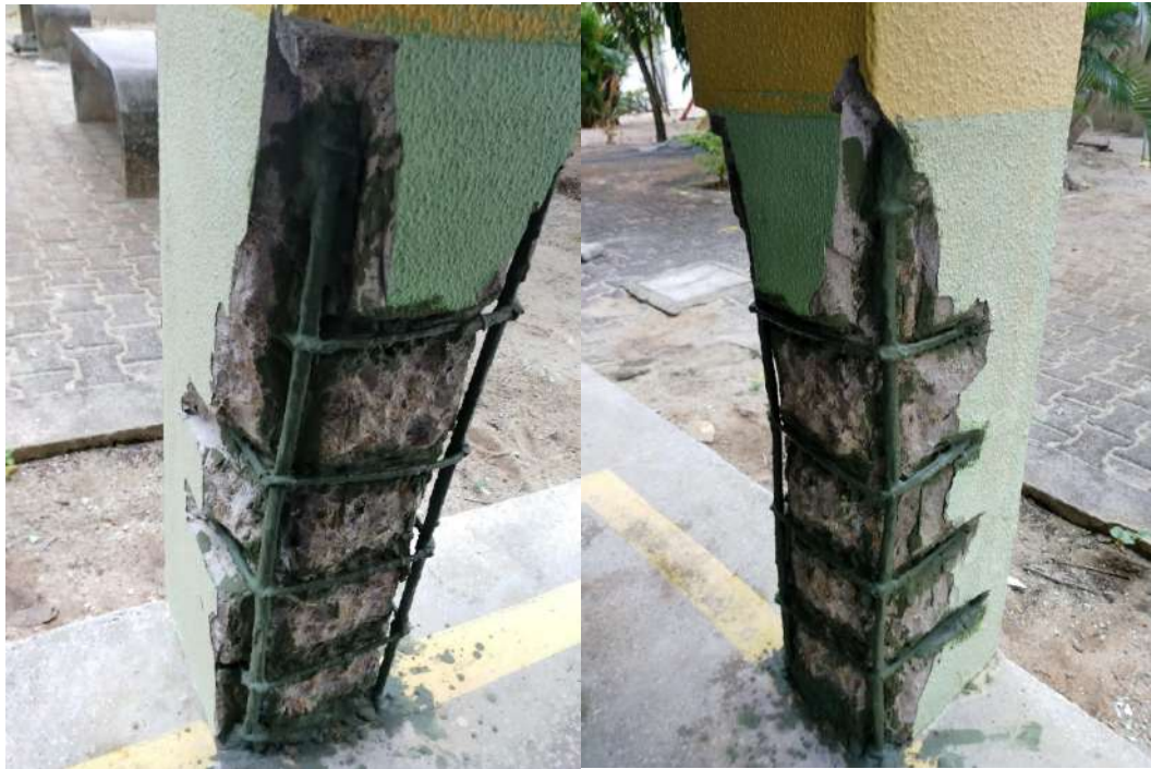
Figura 8. Recuperação dos pilar lado esquerdo. Figura 9. Recuperação dos pilar lado direito. Fonte: própria, 2019.
